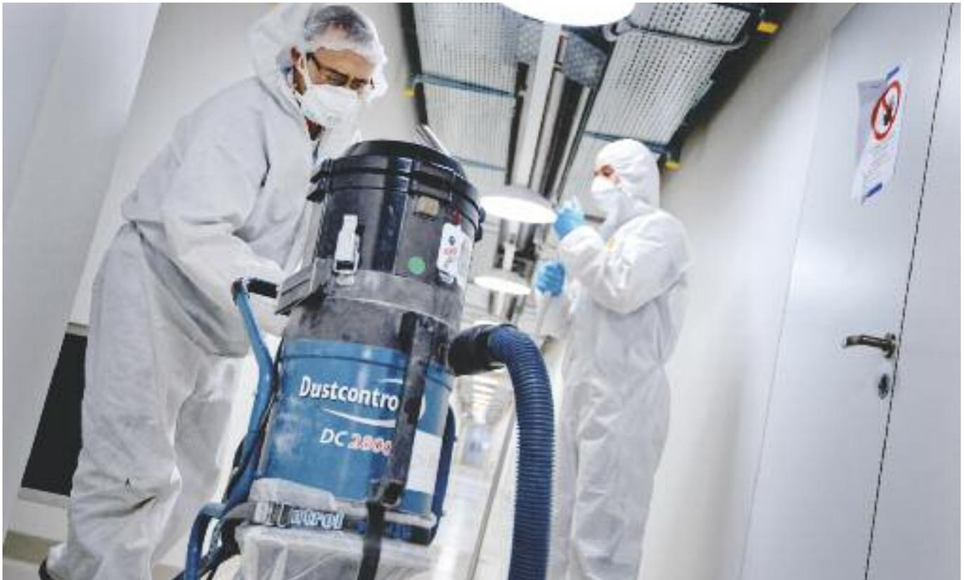
Grobreinigung mit Industriesaugern der M-Klasse mit HEPA H13-Filtern.
